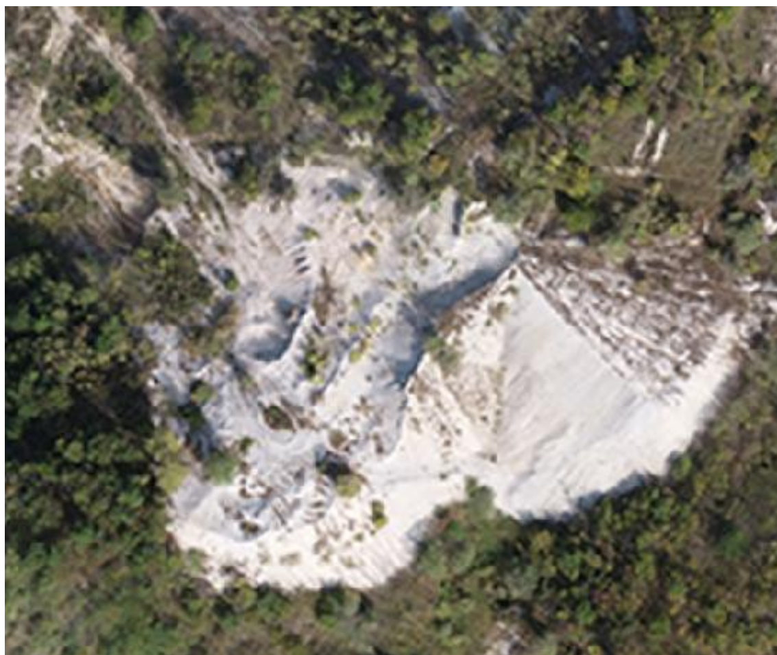
图 3-8 废石场 4 压占损毁土地现状
