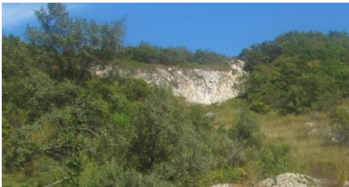
图 3-18 塌陷区 4 损毁土地现状
