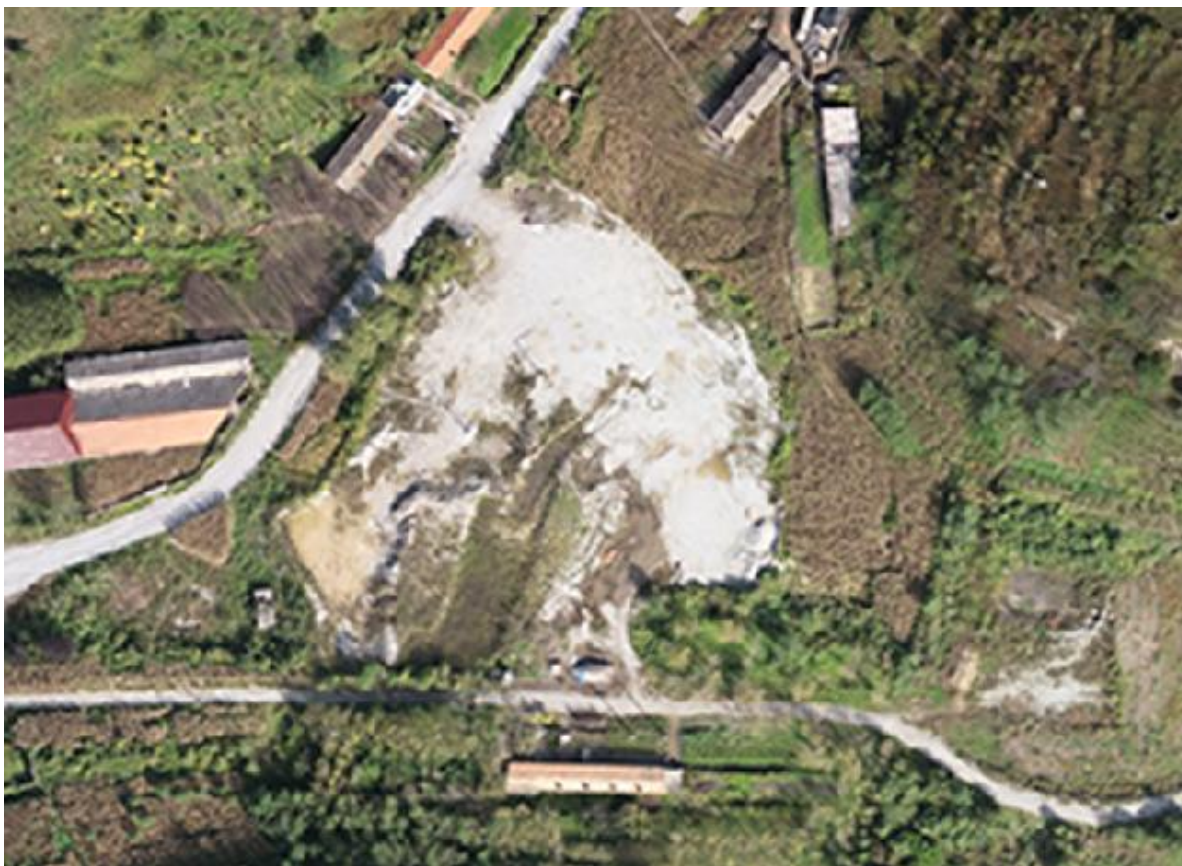
图 3-10 矿石堆场压占损毁土地现状
