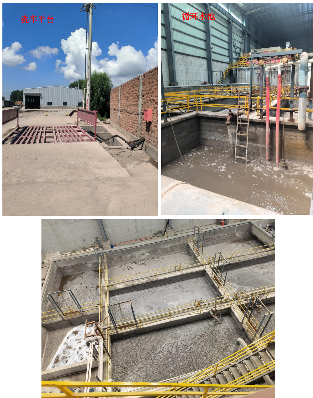
图 2-8 污水处理设施
