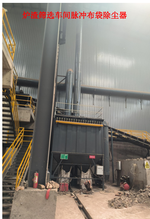
图 2-6 炉渣筛选车间废气收集和治理措施
