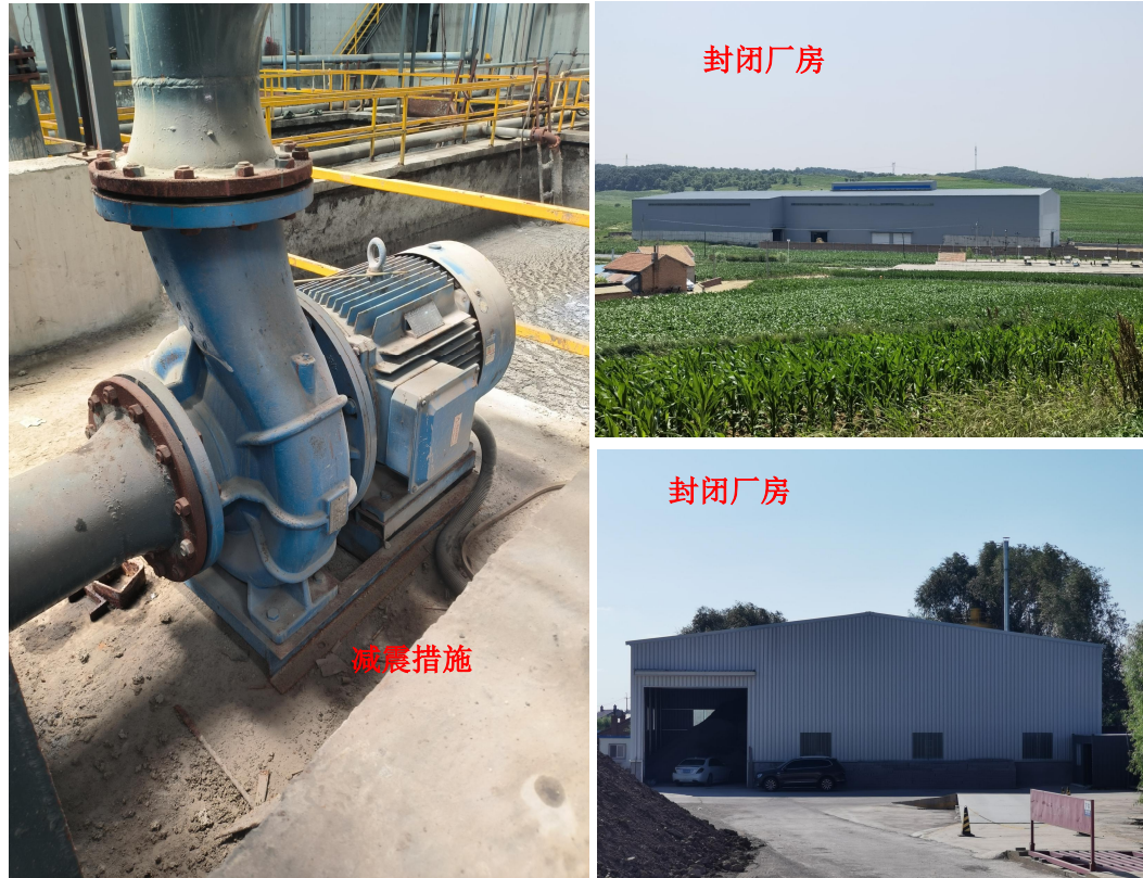
图 2-9 噪声减震、隔声措施
