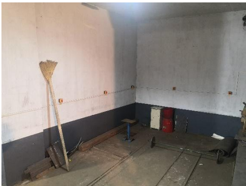
图 10-8 探伤室急停开关
