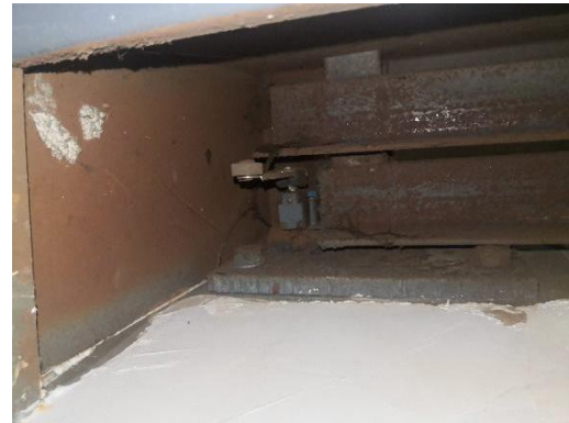
图 10-7 探伤人员门门机联锁
