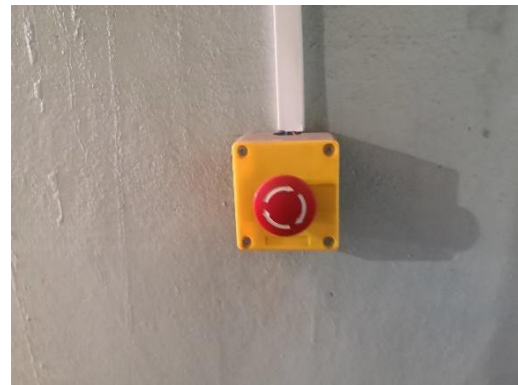
图 10-8 探伤室急停开关
