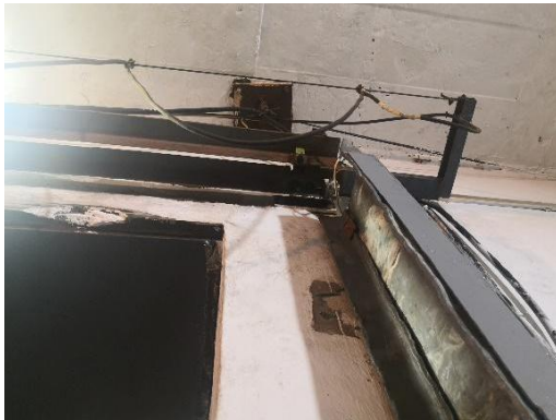
图 10-6 探伤室工件门门机联锁
