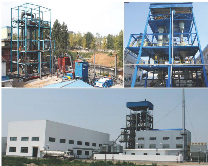
图 3.2-3 流态化两段空气气化的年万吨（上）至 5 万吨（下）中药渣应用工程例 (2) 流态化两段生物质纯氧（富氧）气化实现技术验证
